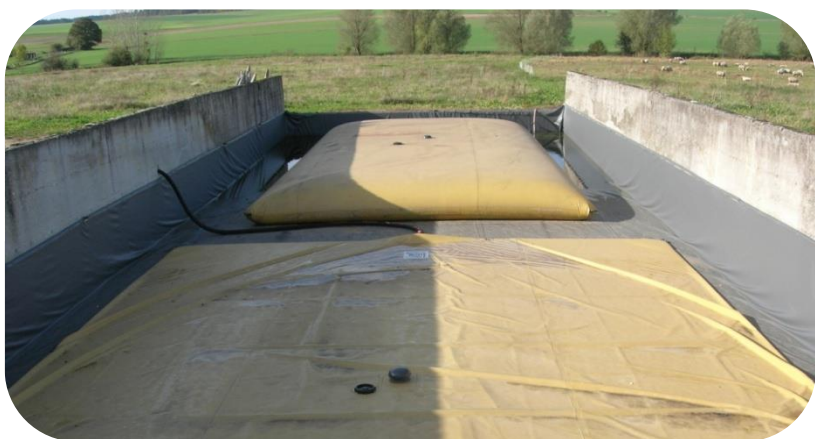
Zbiorniki 60 m 3 zainstalowane w starym silosie
